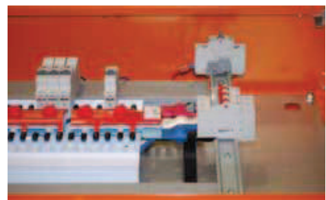
250A IPD Mainswitch or GE DIN Isolator Mainswitch option
